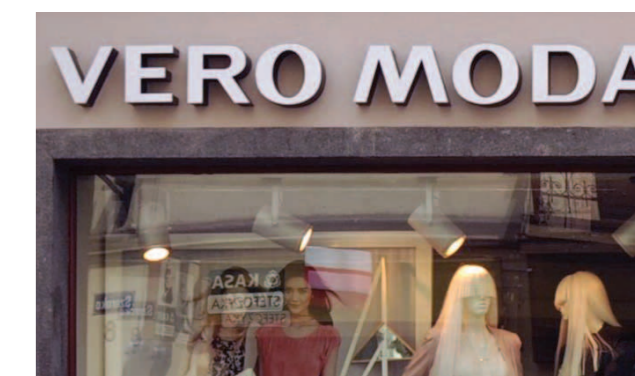
kolor liter przestrzennych harmonizuje z kolorystyką elewacji
