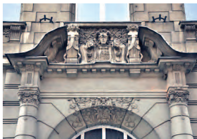
detal kamienicy pod nr. 29
