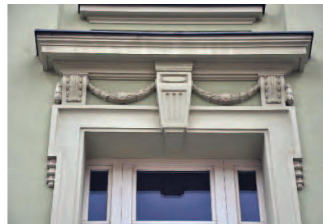
detal kamienicy pod nr. 4
