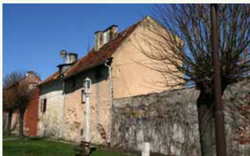
Ilustracja 14. Dobre Miasto, domy przy ul. Sowińskiego, widok od południowego-zachodu, stan przed remontem, fot. I. Liżewska, archiwum NID
