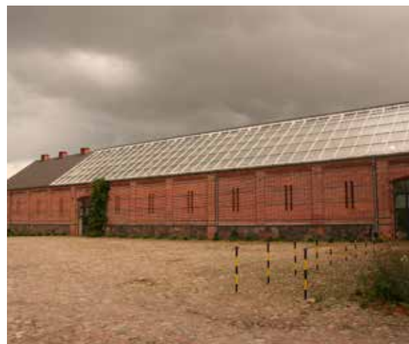
Ilustracja 25. Ten sam obiekt zaadaptowany na oranżerię roślin śródziemnomorskich Botanicznego Ośrodka Badawczo-Wdrożeniowego. Nowa funkcja zachowuje przeznaczenie gospodarcze, bryłę budynku, sylwetę dachu, kompozycję elewacji, oryginalny materiał ścian i fundamentów. Nie generuje niekorzystnych zmian i ingerencji w oryginalną strukturę i materiał, fot. I. Liżewska, archiwum prywatne
